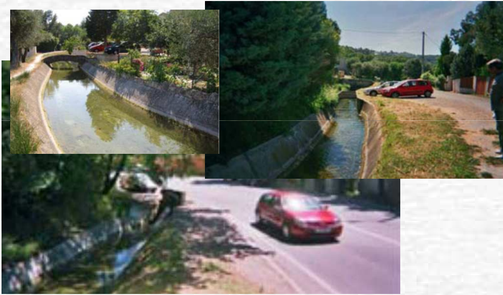
Canal à ciel ouvert
